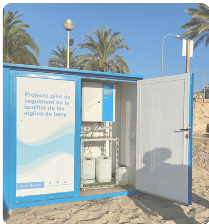
Imagen 2. Instalación del equipo en una playa
