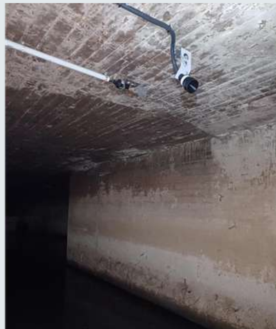
Ilustración 1. Instalación de sensores de nivel y calidad en EDAR (izquierda) y en punto de desbordamiento (derecha).
