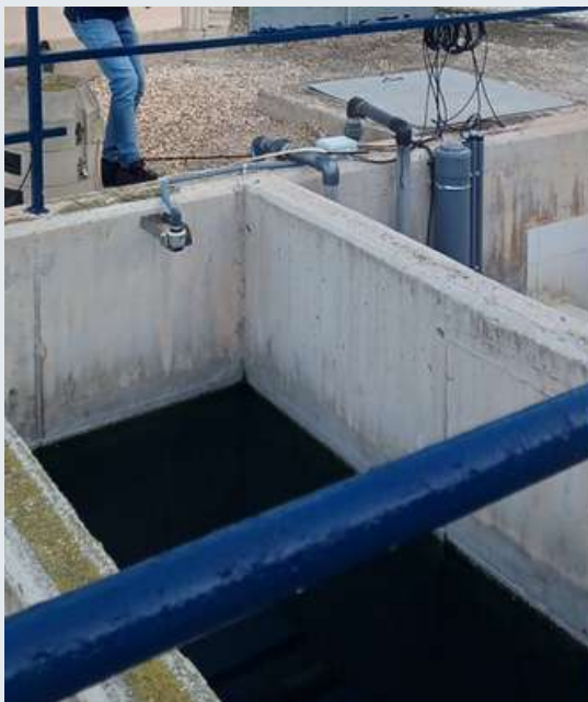
Ilustración 1. Instalación de sensores de nivel y calidad en EDAR (izquierda) y en punto de desbordamiento (derecha).
