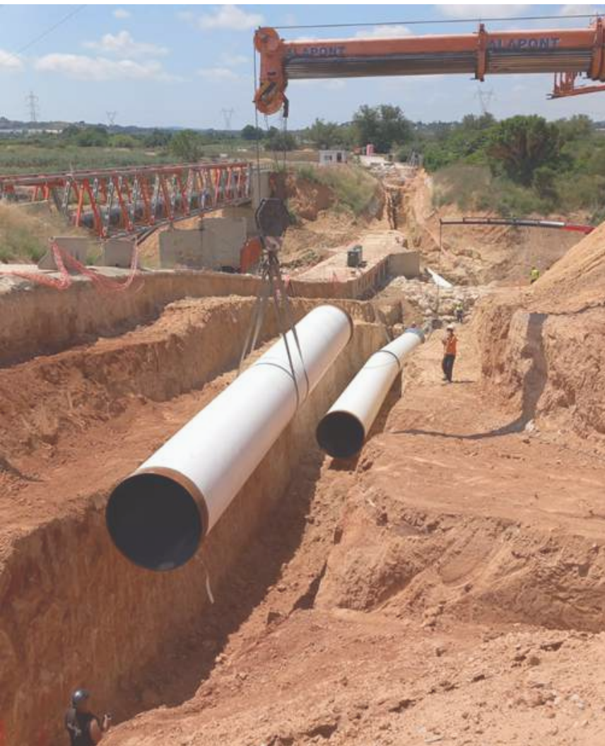
Figura 5. Solución definitiva mediante bypass enterrado
