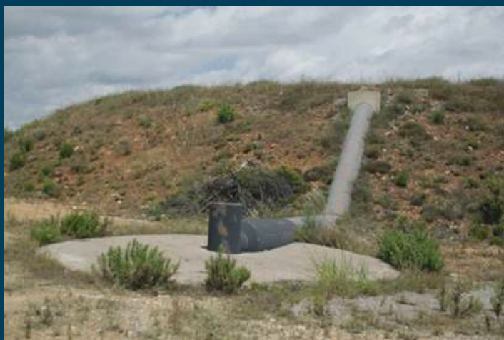
Imagen 2. Sondeo “Balsa del Campo” para drenaje vertical, recarga gestionada y seguridad hídrica
