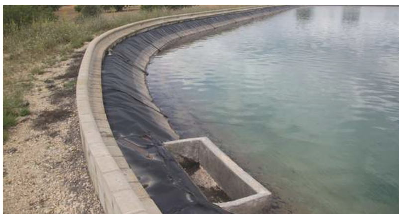
Imagen 3. Bocatoma del sondeo “Balsa del Campo”, que conecta la balsa de riego con el acuífero
