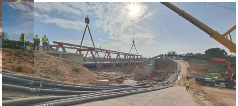
Figura 4. Solución transitoria mediante la construcción de una estructura metálica y conducción por gravedad en acueducto de Horteta
