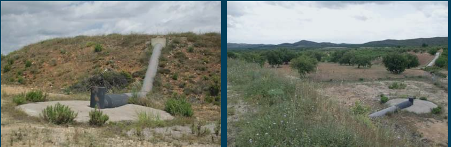
Imagen 2. Sondeo “Balsa del Campo” para drenaje vertical, recarga gestionada y seguridad hídrica
