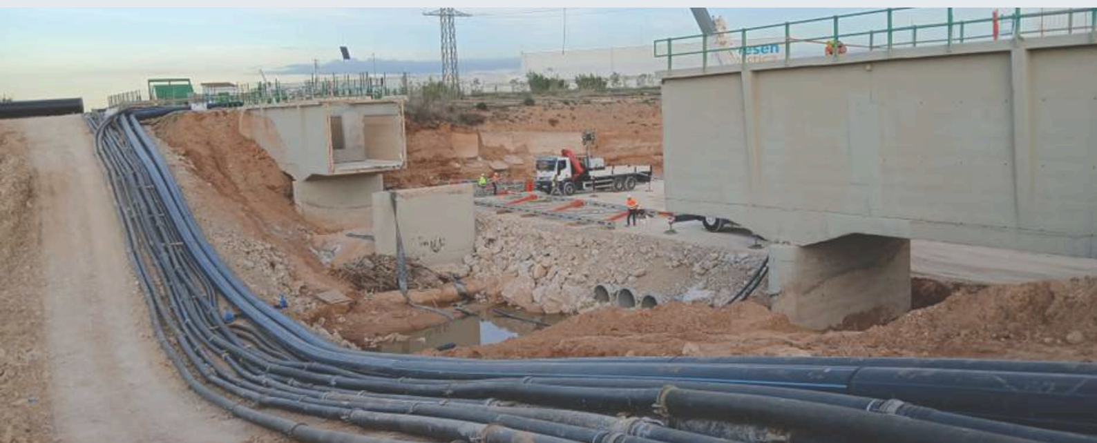
Figura 2. Solución de emergencia mediante grupos motobomba acueducto de Poio
