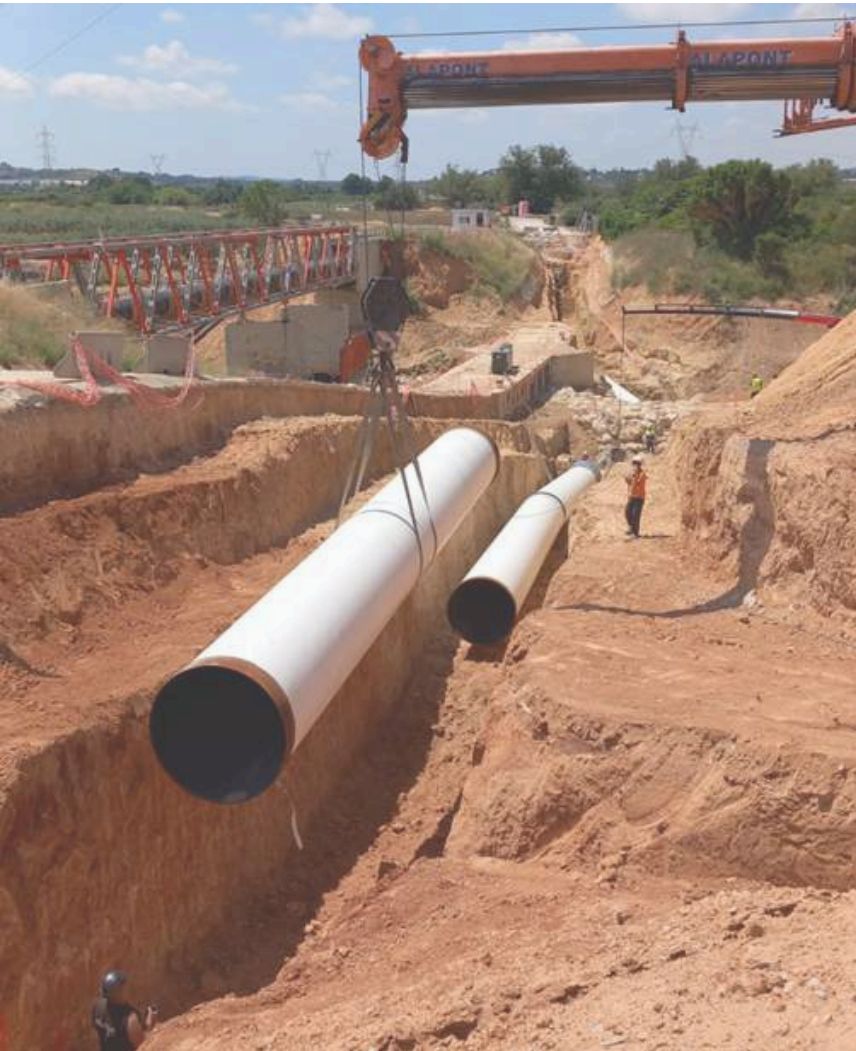
Figura 5. Solución definitiva mediante bypass enterrado
