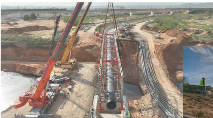
Figura 3. Solución transitoria mediante la construcción de una estructura metálica y conducción por gravedad en acueducto de Poio
